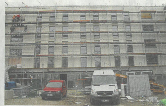
Noch Baustelle: Das neue Horizont-Haus am Bauhausplatz 3.
